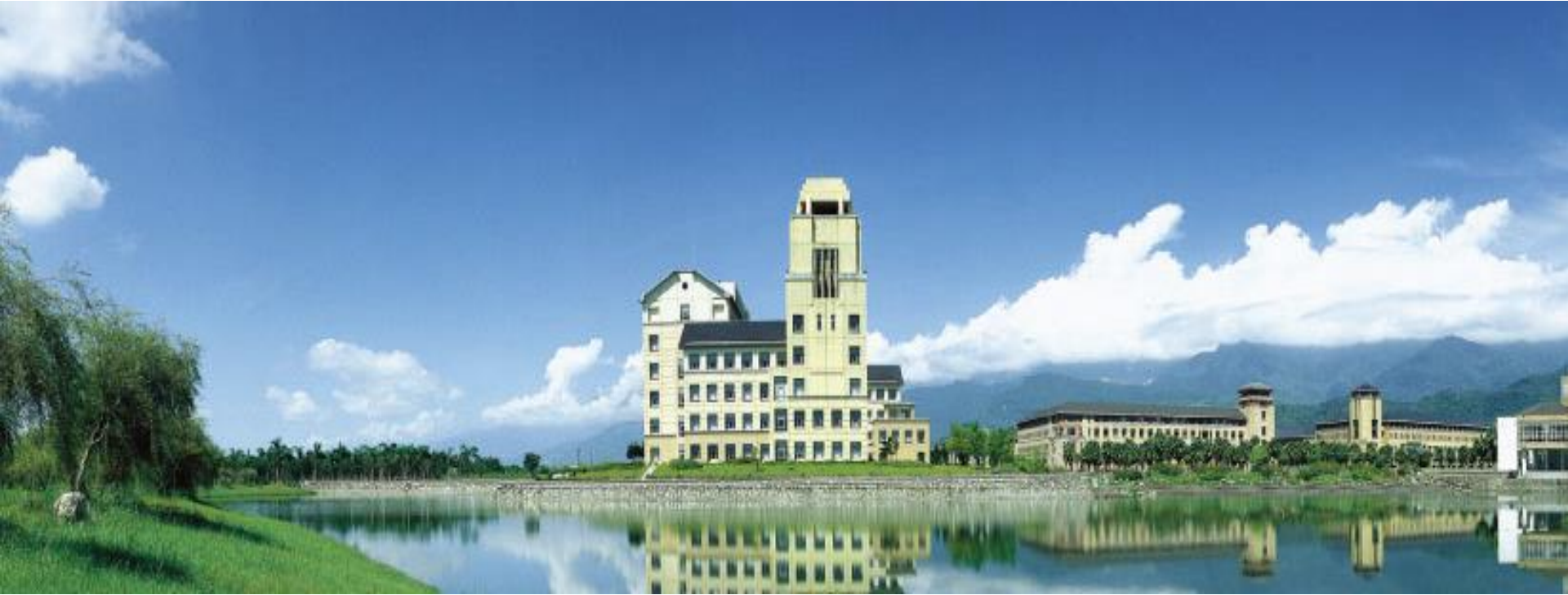
Gedung Administrasi & Gedung Sosial
